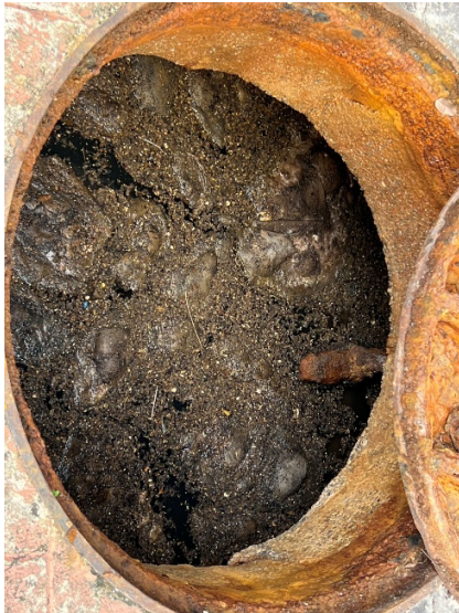
รูปภาพที่ 13 ภาพการกัดกร่อนเหล็ก
