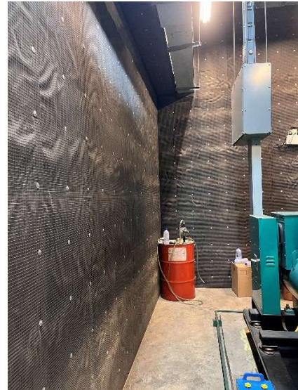
รูปภาพที่ 69 ห้องเครื่องกำเนิดไฟฟ้าสำรอง บุด้วย วัสดุกันเสียง
