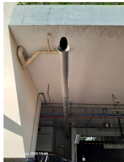
รูปภาพที่ 67 ระบบท่อระบายไอเสีย เครื่องกำเนิดไฟฟ้าสำรอง
