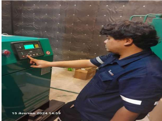
รูปภาพที่ 9 ภาพการทดสอบการทำงานของ เครื่องจ่ายไฟฟ้าสำรอง
