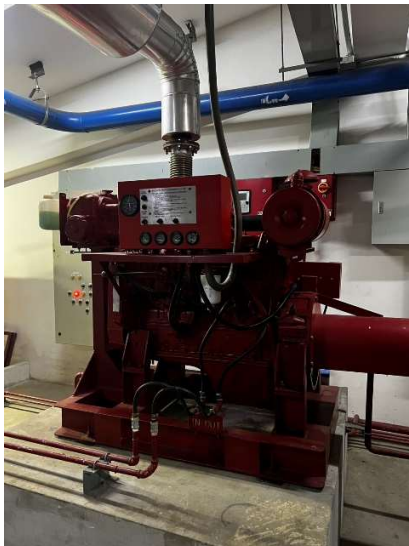
รูปภาพที่ 87 เครื่องสูบน้ำดับเพลิง แบบเครื่องยนต์ ดีเซล ชั้น 1
