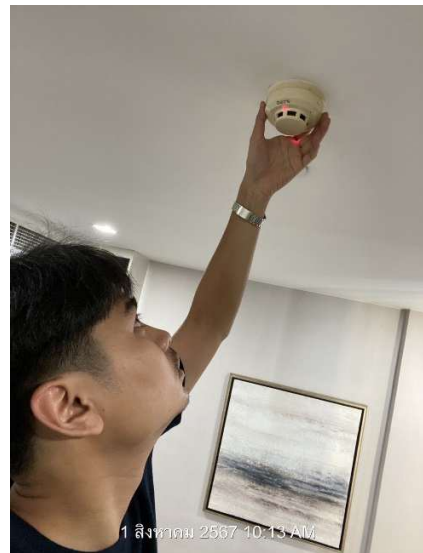
รูปภาพที่ 104 ตรวจสอบระบบไฟอราม ประจำ สัปดาห์
