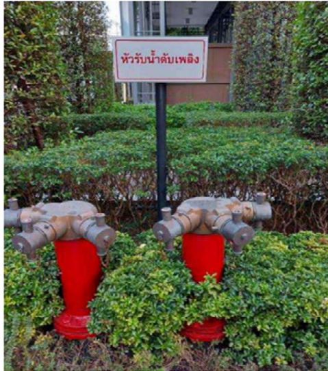
รูปภาพที่ 13 ภาพหัวรับน้ำดับเพลิง ด้านหน้าโครงการ
