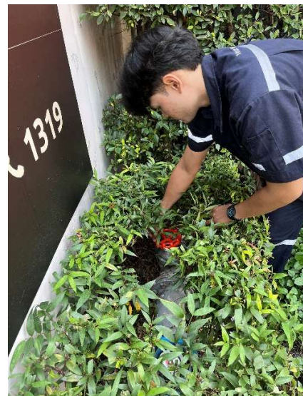
รูปภาพที่ 33 (ต่อ)การปิดวาล์วควบคุมการจ่ายน้ำ จากท่อเมนประปา ตามมาตราการ
