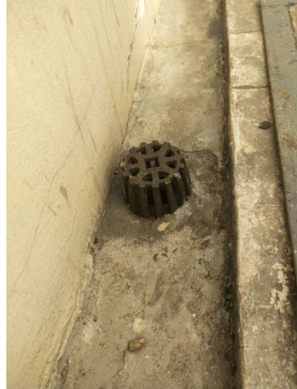
รูปภาพที่ 144 ตะแกรงครอบรูระบายน้ำทิ้ง
