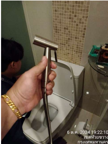
รูปภาพที่ 26 สุขภัณฑ์ประหยัดน้ำสายฉีดชำระ
