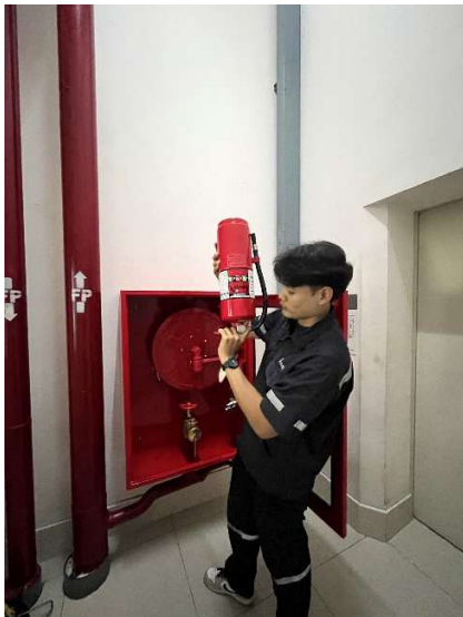
รูปภาพที่ 95 ถังดับเพลิง ติดตั้งภายในตู้ดับเพลิง
