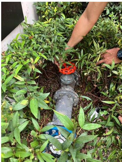
รูปภาพที่ 32 การปิดวาล์วควบคุมการจ่ายน้ำ จากท่อเมนประปา ตามมาตราการ
