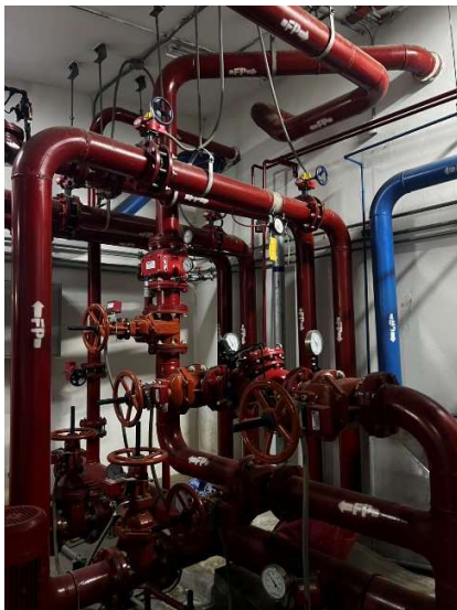
รูปภาพที่ 91 ท่อเมนดับเพลิง จ่าย ชั้น 1-7
