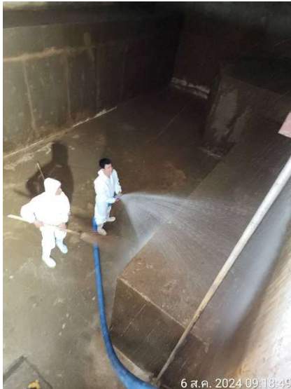
รูปภาพที่ 135 ล้างถังเก็บน้ำประจําปี
