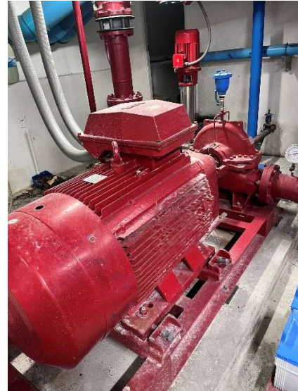
รูปภาพที่ 90 เครื่องสูบน้ำดับเพลิง แบบไฟฟ้า ชั้น 8
