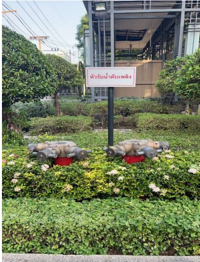
รูปภาพที่ 93 หัวรับน้ำดับเพลิงหน้าอาคาร
